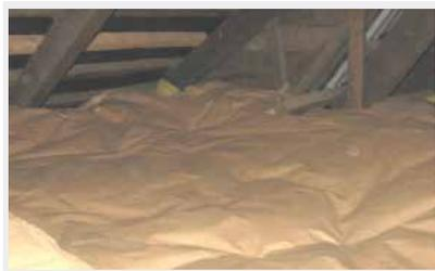
No utilizar como bodega ya que la aislación térmica que posee se puede romper o mover, generando puentes térmicos.
