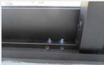
Mantener los despiches (orificios) inferiores de las ventanas libres de tierra y suciedad, esto permite que salga el exceso de agua al exterior.
