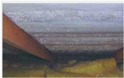
Revisar que no esté tapada la ventilación de la techumbre (respiradero o cumbra de ventilación). De esta forma, se controla que no haya humedad sobre el aislante térmico.
