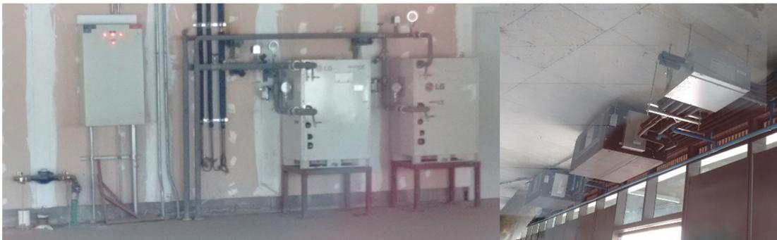
**Ilustración 9. Condensadoras (izquierda) y evaporadora y climatizadora (derecha) al interior de un local comercial**
